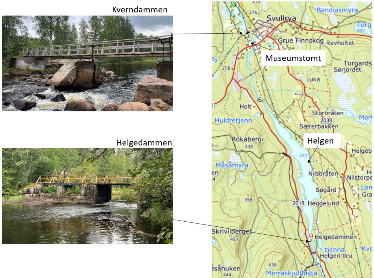
Figur 1-4 Rotnavassdraget forbi Svullrya med damkonstruksjoner.
