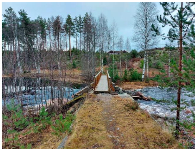
Figur 68. Tursti som fører til dammen.
