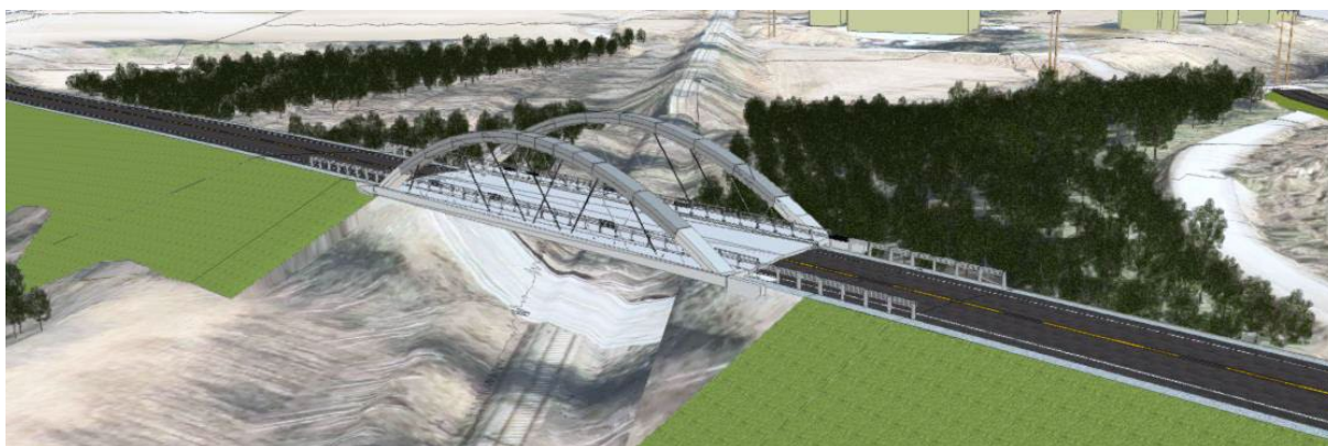
Figur 6-3: Illustrasjon av alternativ med nettverksbuebru med buer i tre.
