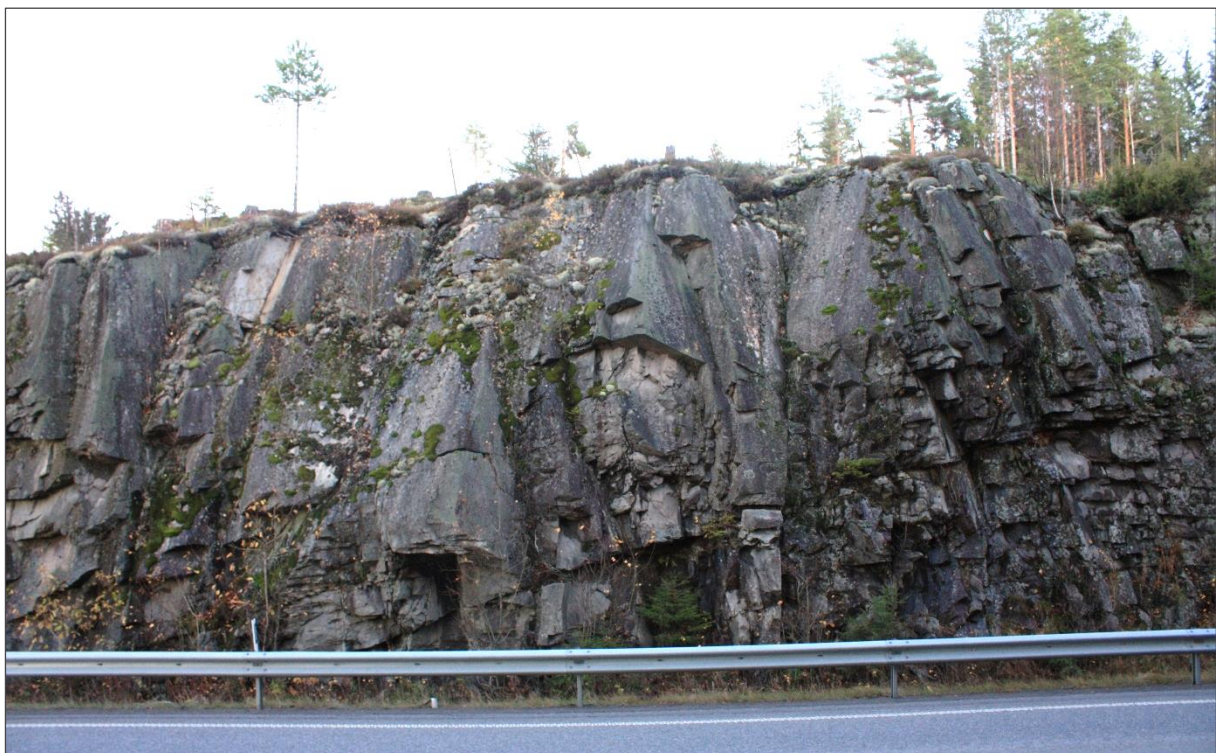
FIGUR 9 Dagens bergskjæring langs Solørvegen, pr. 9180.
